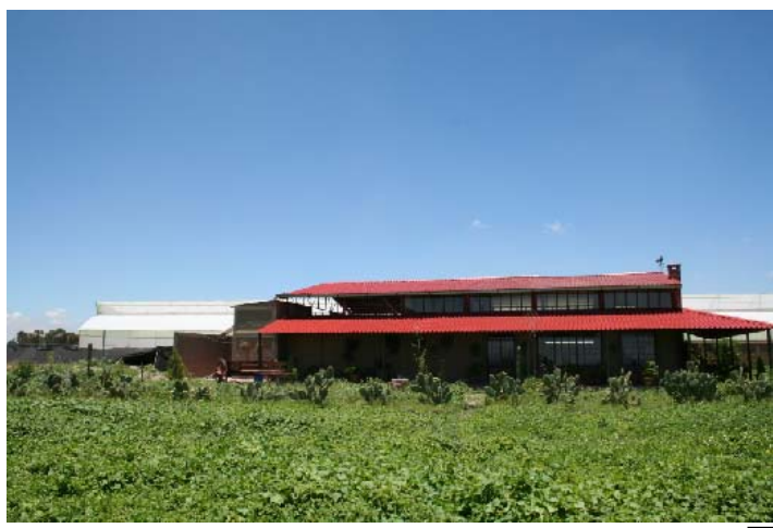
Vista lateral del MSDA, en primer plano la casa con dos niveles con materiales de la región, con iluminación natural y techumbre a dos aguas para la captación del agua de lluvia que abastece a la casa y al bioespacio (segundo plano).
