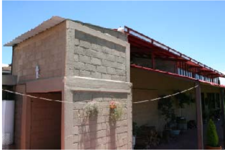
Cisterna con capacidad de 10,000 litros de agua para el servicio de la casa-habitación, se aprecia la canaleta que recoge y alimenta dicha cisterna.
