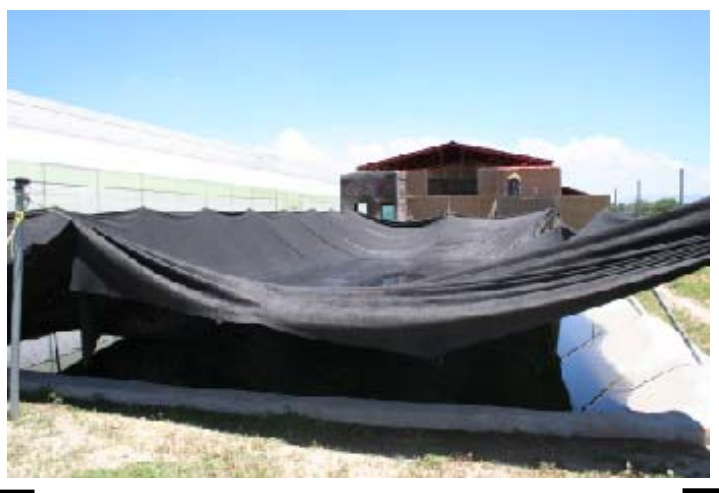
Vista posterior del MSDA, el bordo u olla de agua que almacena el agua de lluvia captada por la superficie de la techumbre de la casa, con la que se produce en el bioespacio y atiende necesidades de la casa-habitación.
